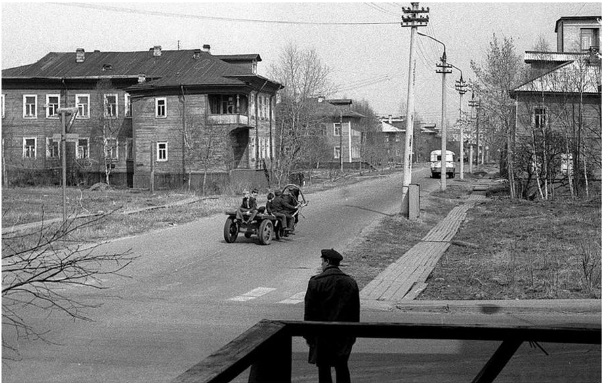
Деревянные дома на углу улицы К. Либкнехта и проспекта Ломоносова в Архангельске, фотография начала 70-х
