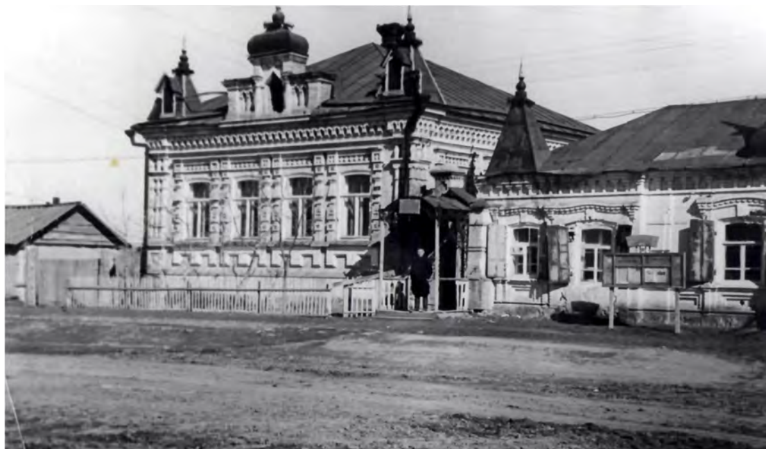
Село Быково. Здание Госбанка
