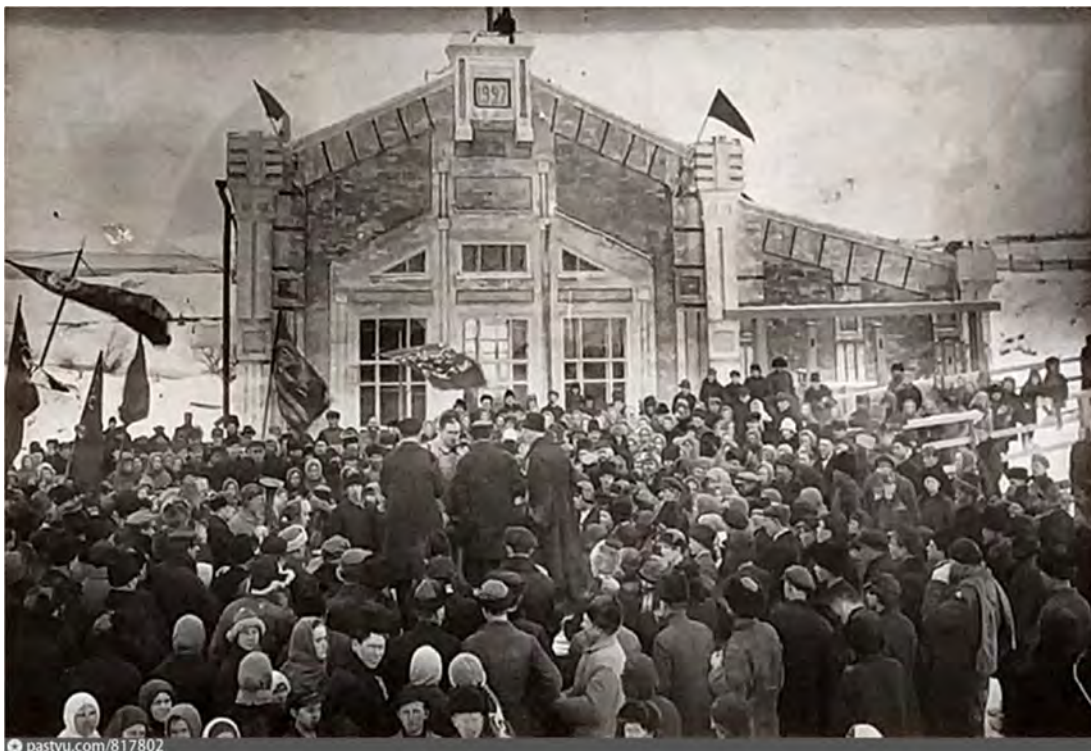
Сдача в эксплуатацию гидростанции в деревне Полетаево, 1927 год
